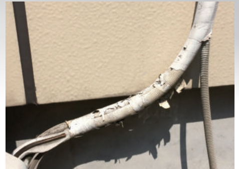
Isolation ohne UV-Schutz, die durch Sonneneinstrahlung beschädigt wurde
