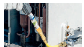
Injektion des Färbemittels durch Drehen des Griffs.
